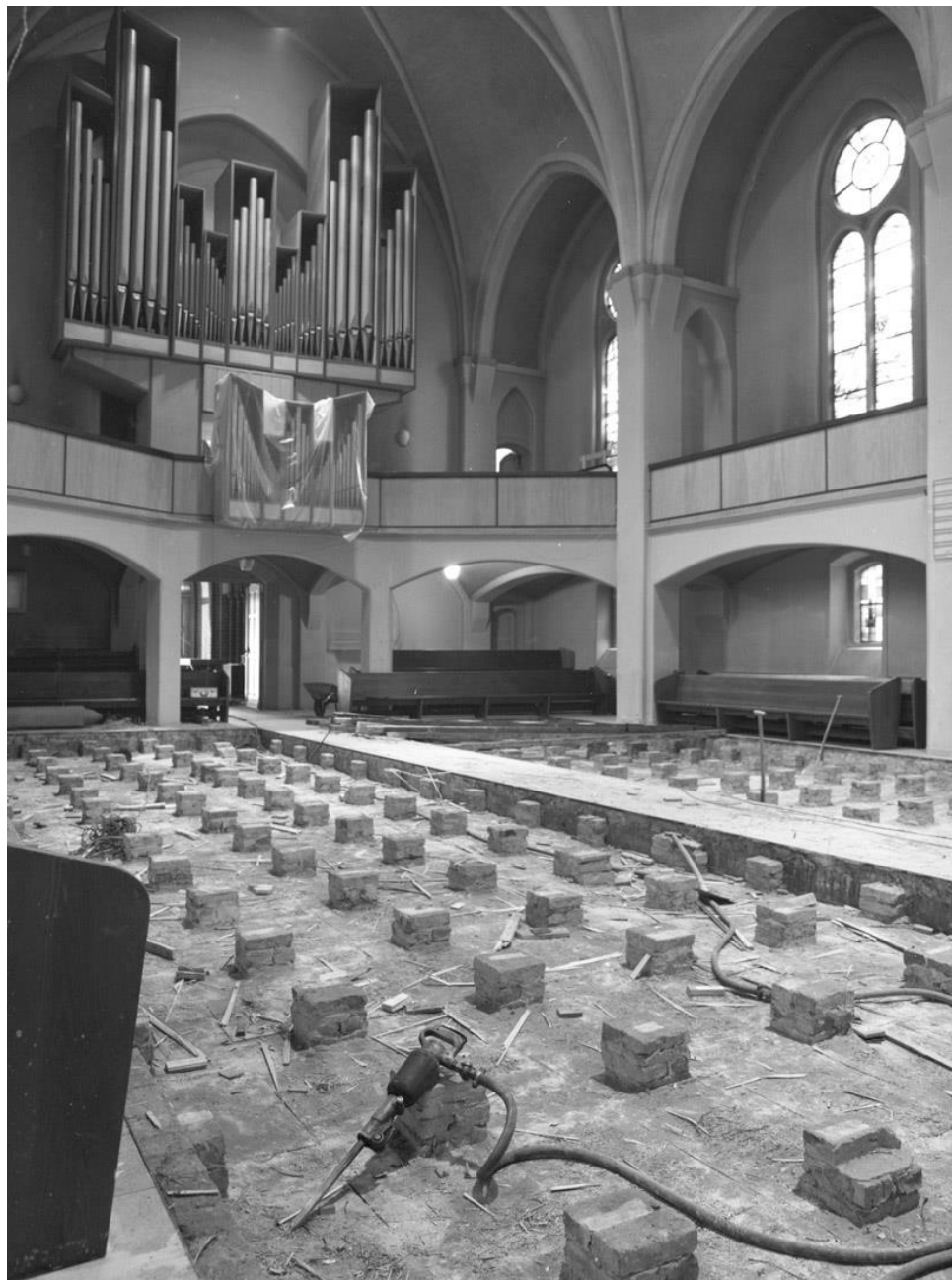
Während des Heizungseinbaus. Der Fußboden ist herausgenommen.
